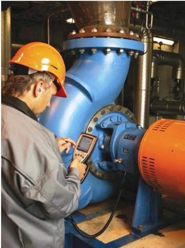
*El análisis de vibraciones es una forma efectiva de detectar fallas prematuras en rodamientos y las condiciones que pueden conllevar a carga excesiva de rodamientos y ultimadamente una falla por fatiga en los mismos (fotografía cortesía de SPM Instrument).*
