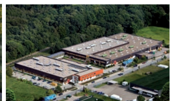
Planta de mecanizado NORD Gadebusch
