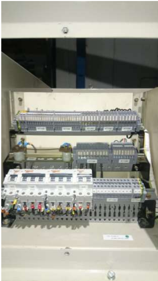
Imagen 2 Placa de bornes y de transformadores de medida , revisada saneada
