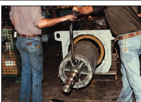
Figura 17. Extracción de rotor usando una herramienta diseñada para desmontaje de rotores.
